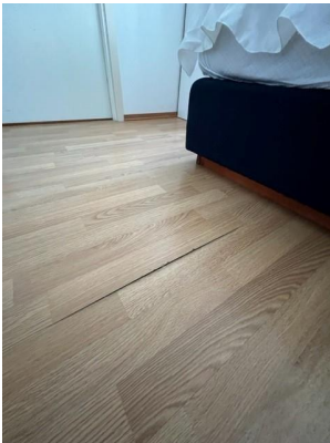
Fuktskade i laminat i soverom.
