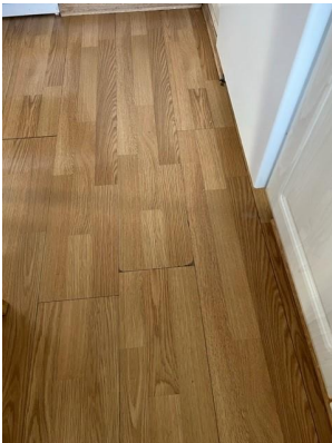
Fuktskade i laminat i soverom.
