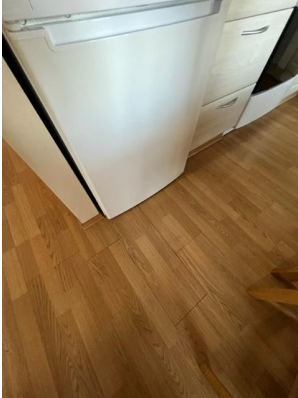
Fuktskader i laminat foran kjøleskap.
